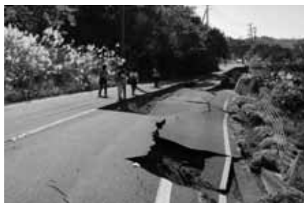
図2 ▶ 2004年新潟県中越地震での道路損壊
