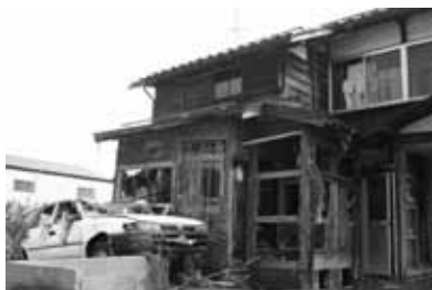
図4▶2004年新潟豪雨災害での家屋被害
